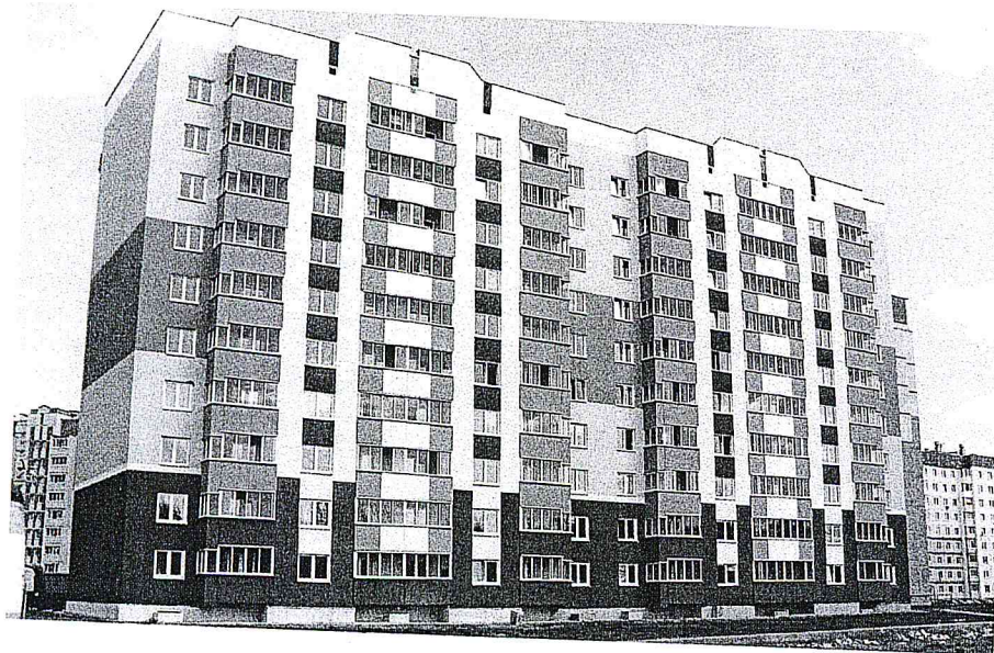
Жилой дом со сборным каркасом нового поколения в г. Новополюцке
