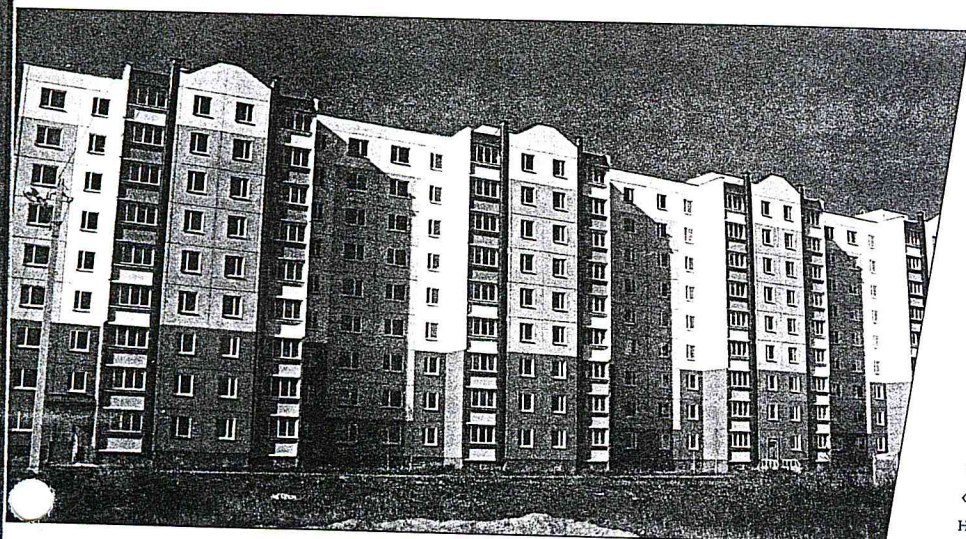
Рис. 1. Энергоэффективное панельное здание серии 111-90 МАПИД в г. Минск.
